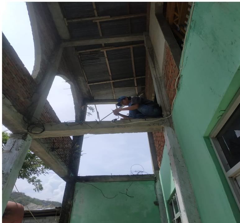
Gambar 5.4. Pemasangan instalasi listrik bagian timur masjid
