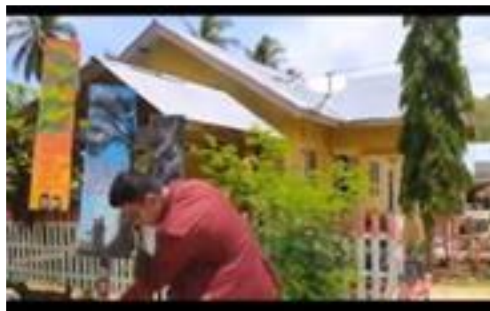
Gambar 13. Proses Pemasangan Papan informasi (Sumber:penulis)
