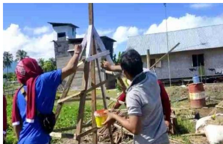
Pengecatan Kerangka
