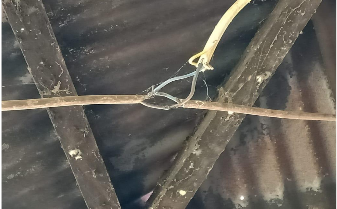
Gambar 4. Sambungan Kabel Yang Tidak Menggunakan Isolasi yang Sebenarnya
