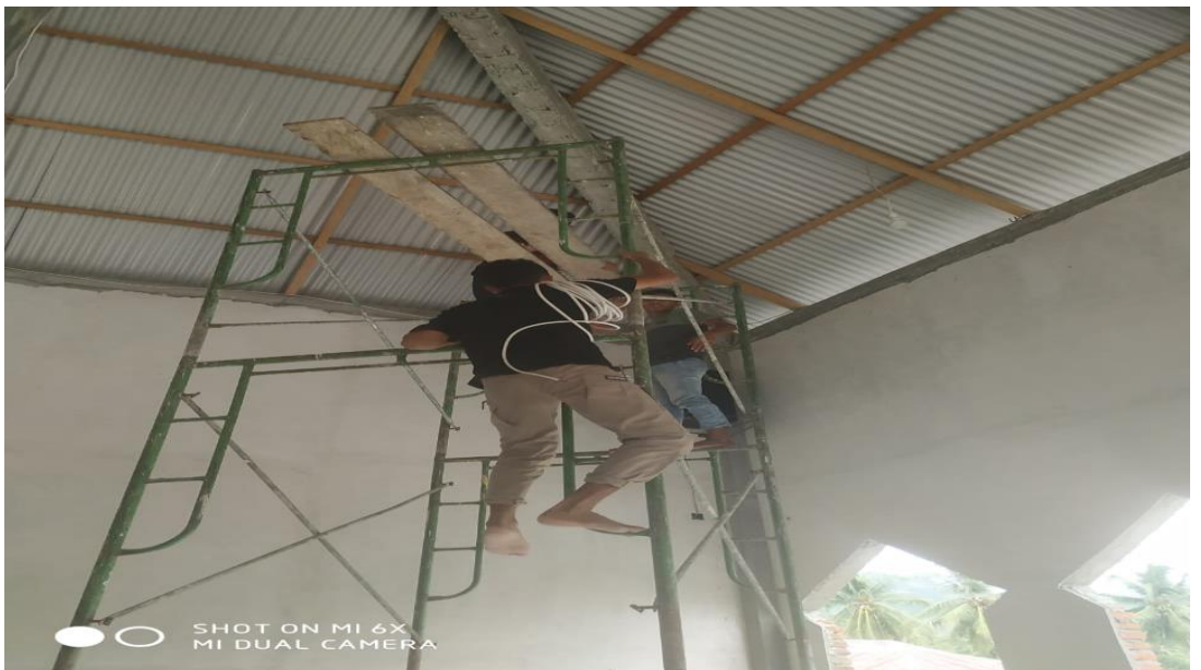
Gambar.4 Pemasangan Instalasi Mesjid Al-Iqro
