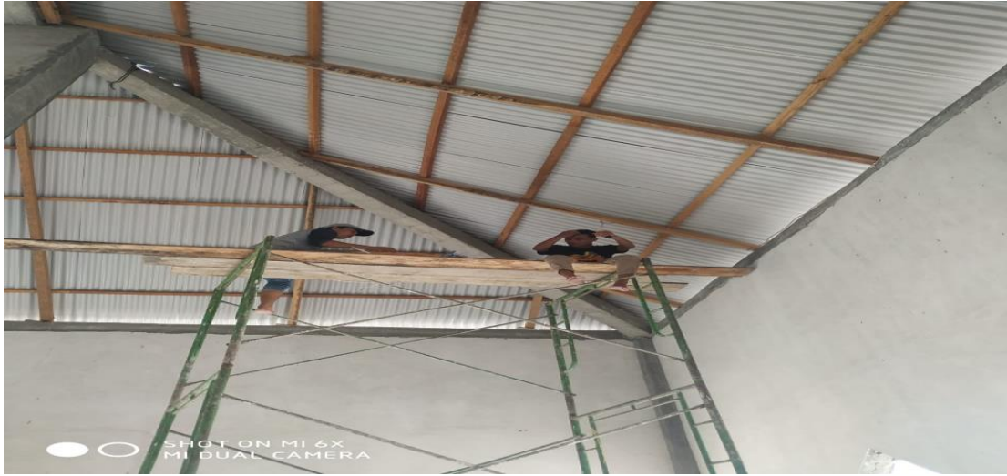
Gambar.5 Pemasangan Instalasi Mesjid Al-Iqro
