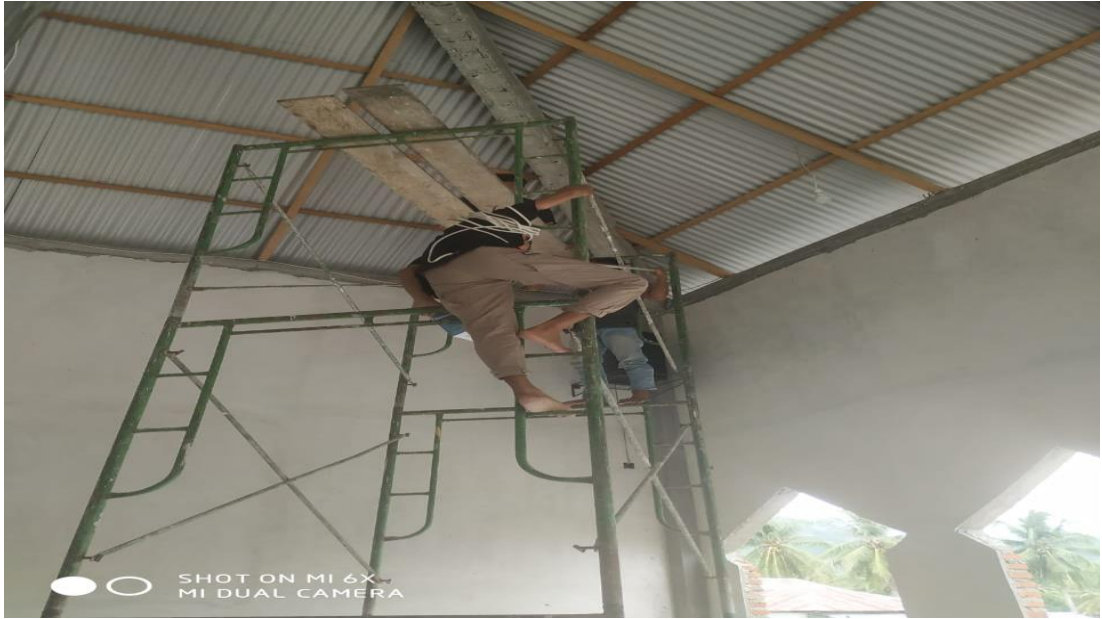
Gambar.3 Pemasangan Instalasi Mesjid Al-Iqro
