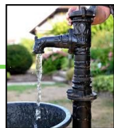
SUMUR DENGAN POMPA TANGAN
