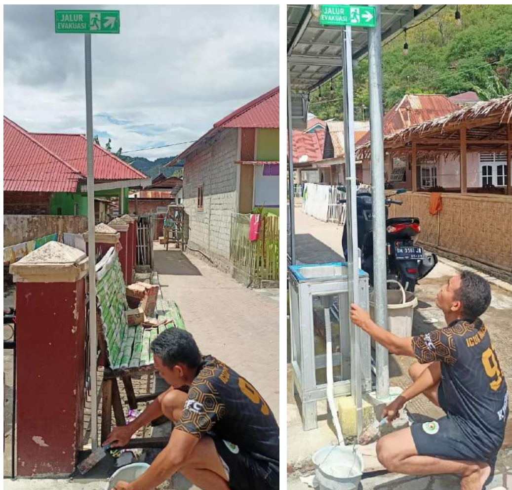
Gambar 11. Pemasangan Rambu Jalur Evakuasi
