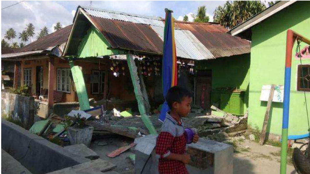
Gambar 1. Kerusakan Bangunan Akibat Bencana Gempa
