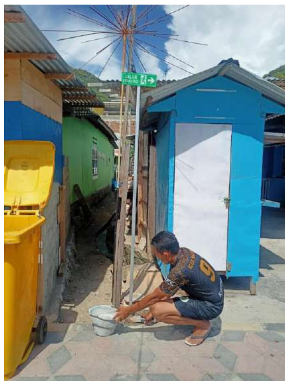
Pemasangan Rambu Jalur Evakuasi
