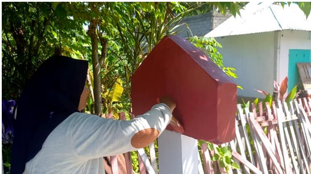
Gambar 27. pengecatan Batas Dusun dan Desa
