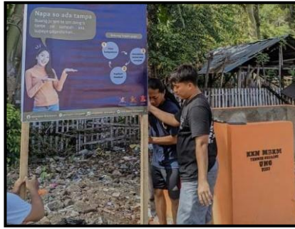
Gambar 4. Pembuatan Bak Sampah dan Pemasangan Papan Informasi
