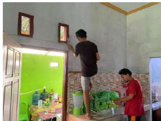
Gambar 22 Instalasi Rumah Warga
