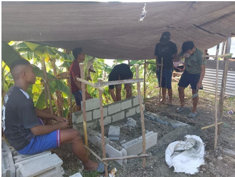
Gambar 40 pembuatan bak sampah
