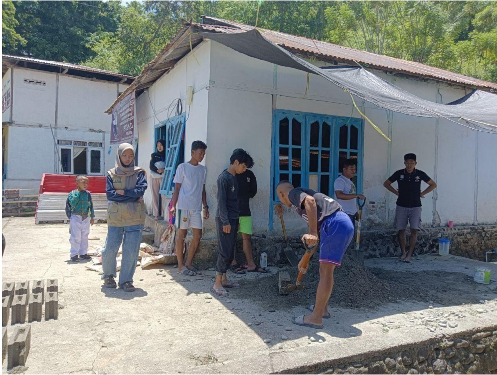
Dokumentasi 11 pengerjaan batako
