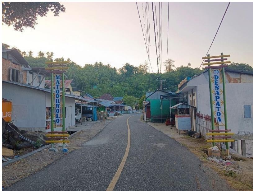
Gambar 29 hasil pengerjaan gapura Sumber: dokumentasi pribadi
