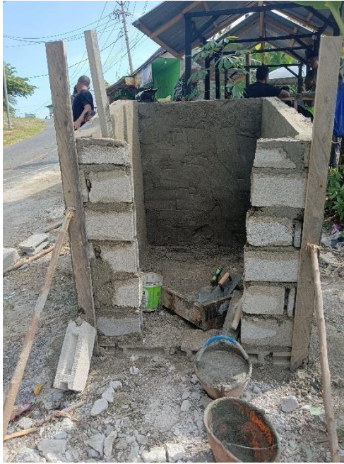
Gambar 41 pengecoran bak sampah
