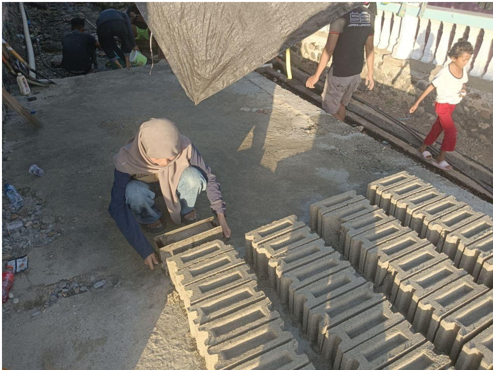
Dokumentasi 12 penyelesaian batako
