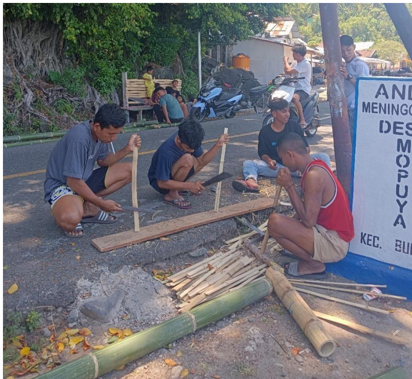
Dokumentasi 22 pengerjaan gapura
