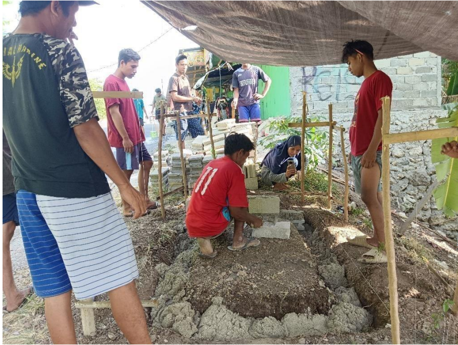
Dokumentasi 19 pengerjaan bak sampah
