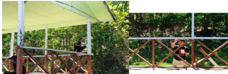
Gambar 2. 9 Pembinaan Fasilitas Pantai (Pengecatan)
