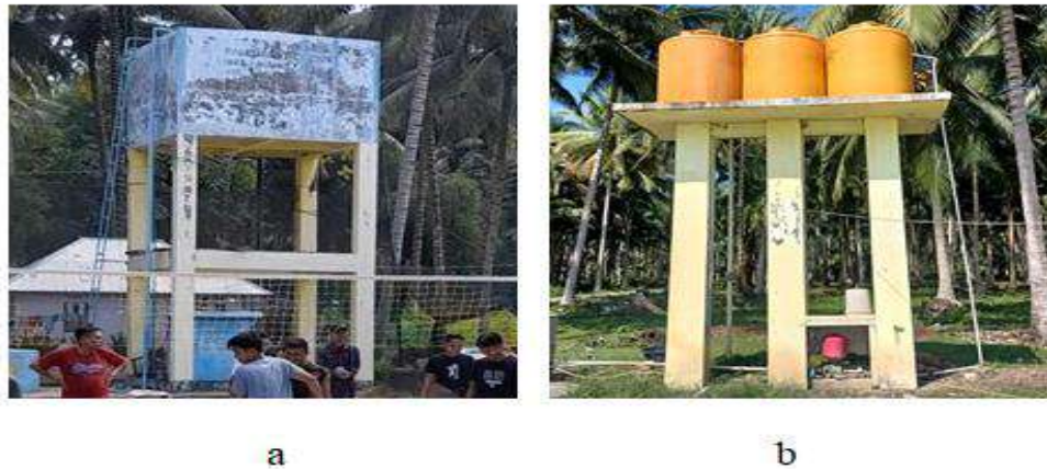
Gambar 4. Bangunan fisik PAMSIMAS di Dusun III
