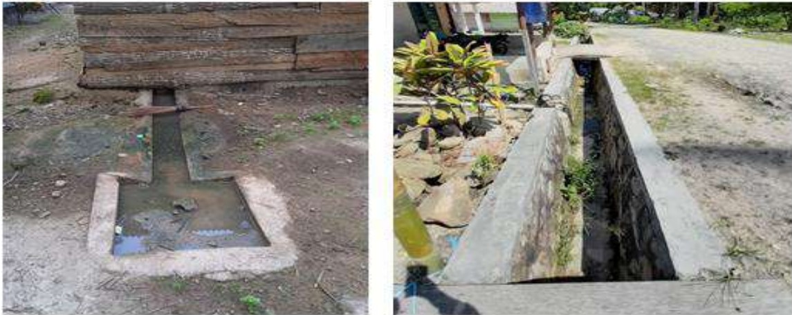
Gambar 8. Kondisi Drainase di Desa Rumbia a) Sumur Resapan b) Drainase
