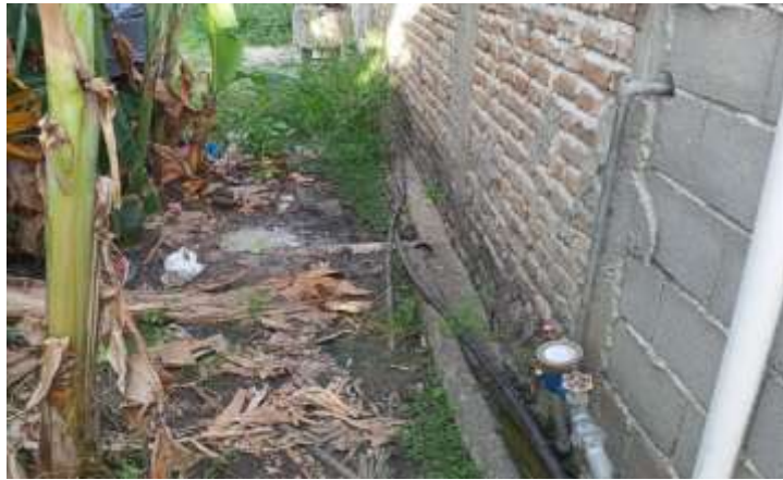
Gambar 4.2. Saluran Pembuangan Air Limbah yang Tidak Terpelihara
