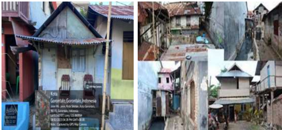
Gambar 4.17. Rumah Tidak Layak Huni
