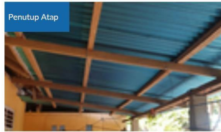
Gambar 4. 61 Kondisi Penutup Atap
