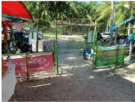
Gambar 4. 5 Pintu Gerbang yang Belum Menarik
