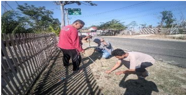
Dokumentasi 43. Melakukan Penggalian Tanah Untuk Pemasangan Pipa PAMSISMAS
