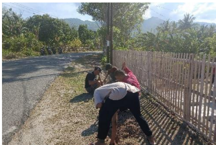
Gambar 4. 65 Perbaikan Jaringan Utilitas Pemipaan Air Bersih di Permukiman
