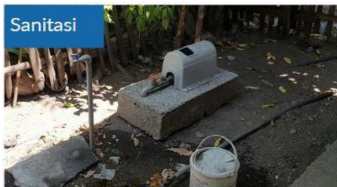
Gambar 4. 62 Kondisi Sanitasi pada Rumah Hasil Survey
