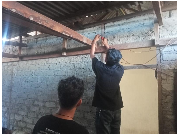
Gambar 4. Pelaksanaan kegiatan perbaikan instalasi listrik penerangan
