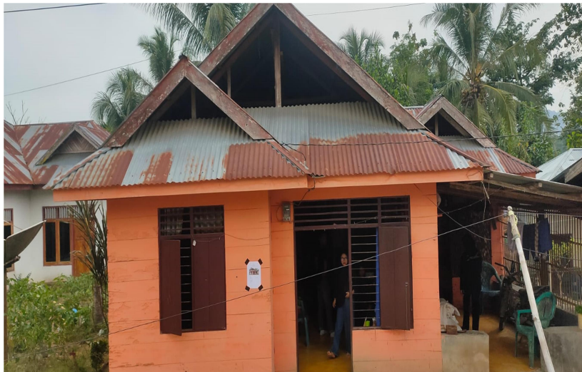
Gambar 2. Salah satu rumah yang dilakukan perbaikan instalasi
