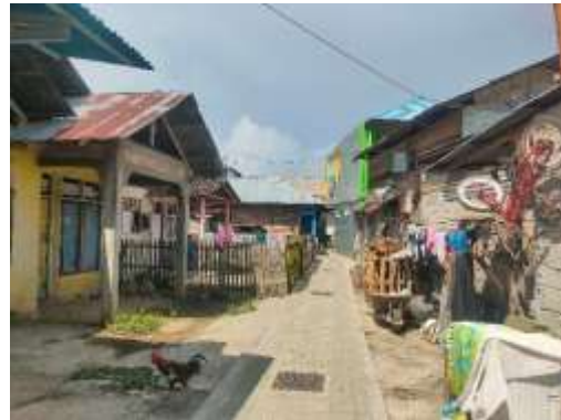
Gambar 3.3 Ketidakteraturan Bangunan (Sumber: Penulis, 2024)
