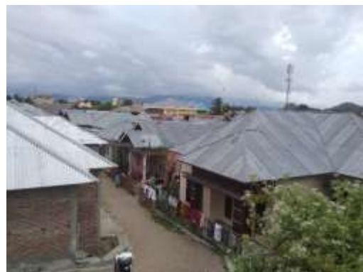
Gambar 3.1 Ketidakteraturan Bangunan (Penulis: 20204)
