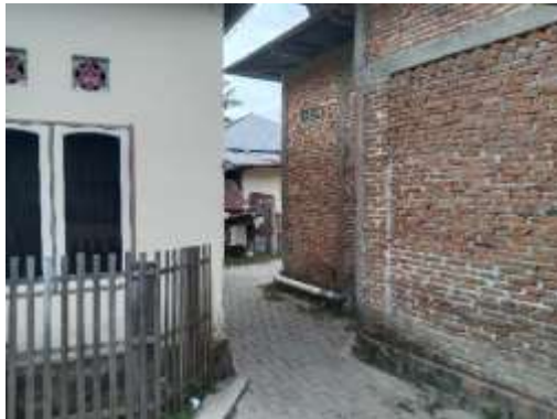
Gambar 3.4 Ketidakteraturan Bangunan (Sumber: Penulis, 2024)
