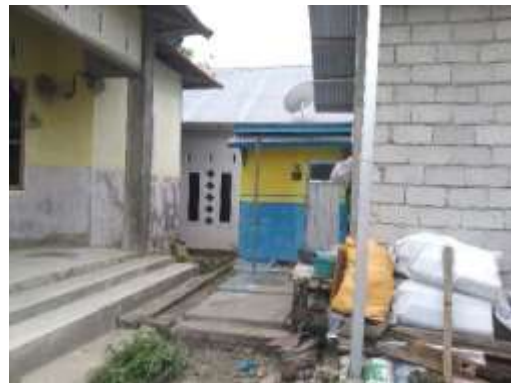
Gambar 3.28 Septick Tank (Sumber: Penulis 2024)
