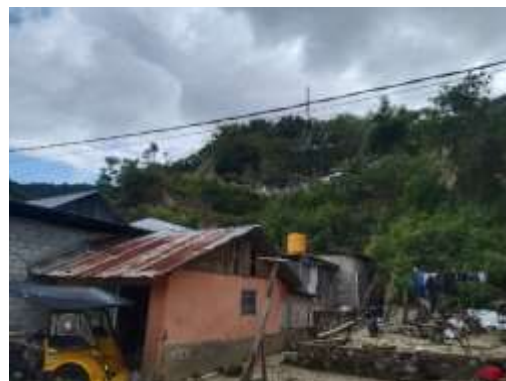
Gambar 3.9 Konstruksi Tidak Sesuai (Sumber: Penulis 2024)
