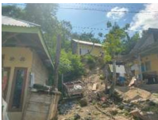
Gambar 3.12 Konstruksi Tidak Sesuai (Sumber: Penulis 2024)
