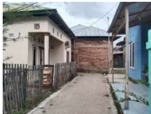
Gambar 3.16 Jalan Paving Block (Sumber: Penulis 2024)
