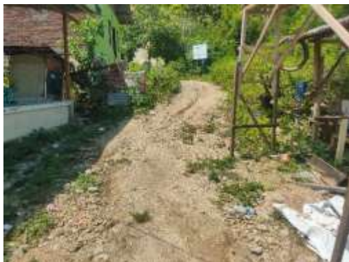
Gambar 3.17 Jalan Tanpa Perkerasan (Sumber: Penulis 2024)
