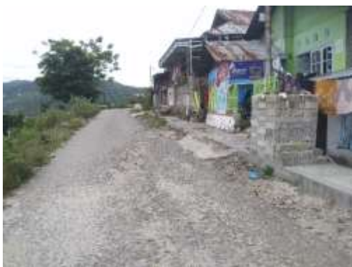
Gambar 3.21 Drainasi di 1 Sisi Jalan (Sumber: Penulis 2024)
