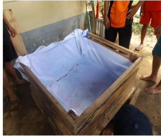
Gambar 6. Tahap Pembuatan BAK Fermentasi
